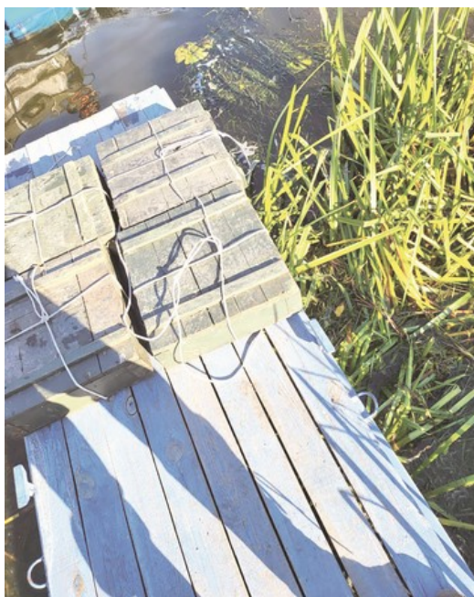
Фото 3. Применение ящиков с песком в качестве пригруза
