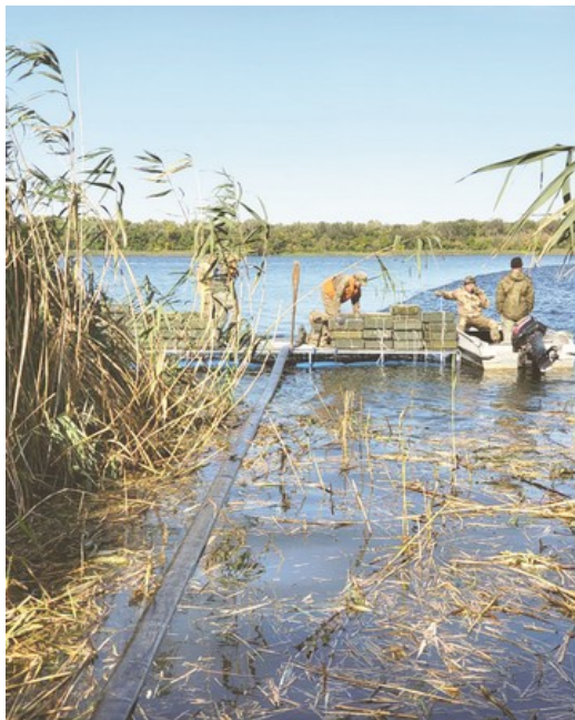
Фото 2. Установка пригрузов на развернутой линии трубопровода
